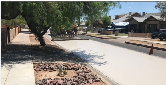
El pavimento frío es un tratamiento de asfalto a base de agua que se aplica sobre el pavimento de asfalto existente.
