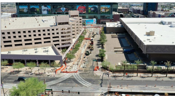
La construcción ferroviaria continúa en South Central Extension / Downtown Hub.
