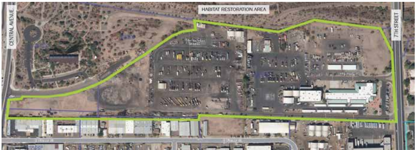
Futuro Sitio de Reurbanización de Propiedad Municipal
