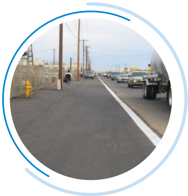
Antes y después de la estabilización de la superficie en las orillas de la Avenida Broadway
